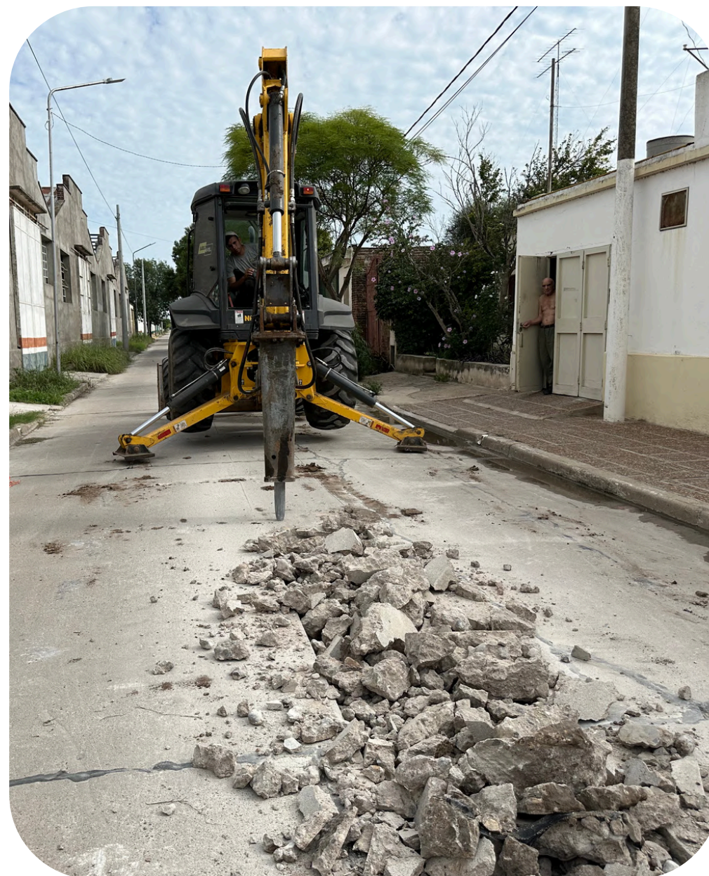
INICIO DE LA AMPLIACIÓN RED COLECTORA CLOACAL
